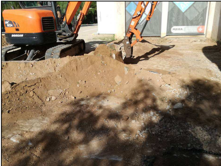
Fotografia núm. 8: execució del rebaix general sobre l'àrea del porxo
