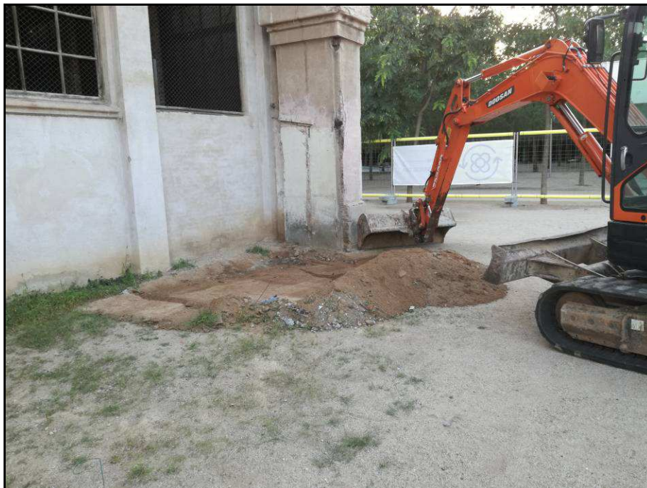
Fotografia núm. 6: inici del rebaix general sobre l'àrea del porxo
