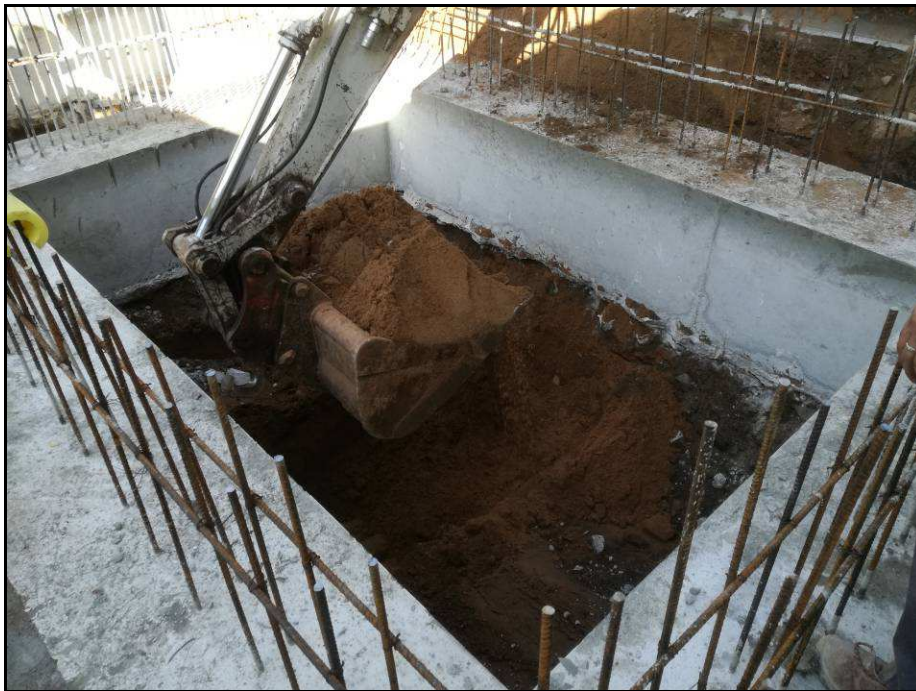
Fotografia núm. 85: Rebaix del fossat d'ascensor
