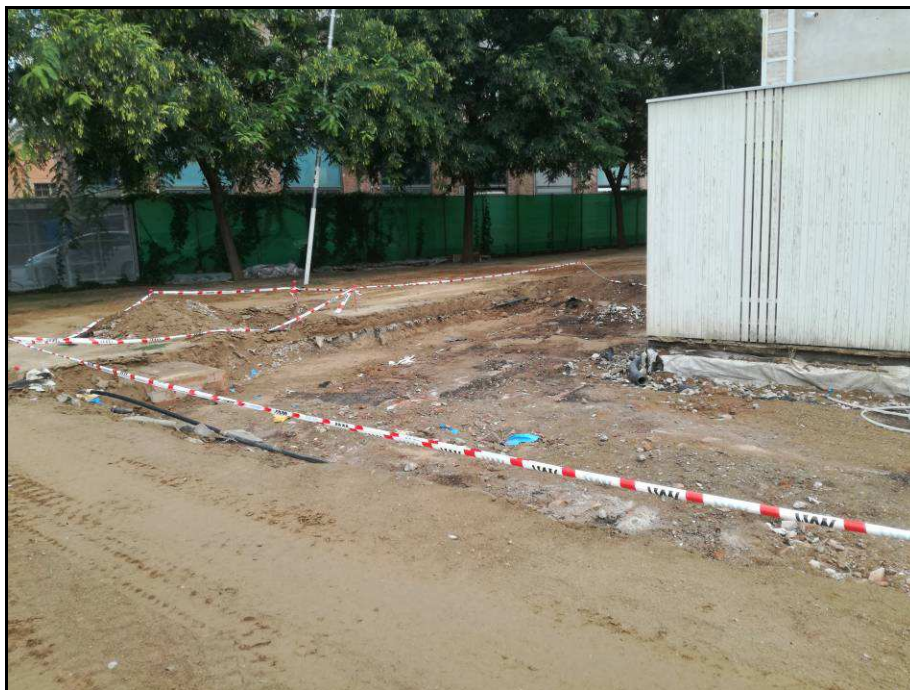
Fotografia núm. 15: rebaix general sobre l'àrea del porxo un cop finalitzat
