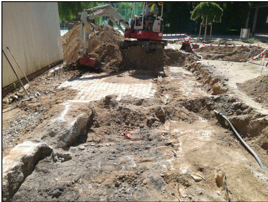
Fotografia núm. 13: execució del rebaix general sobre l'àrea del porxo
