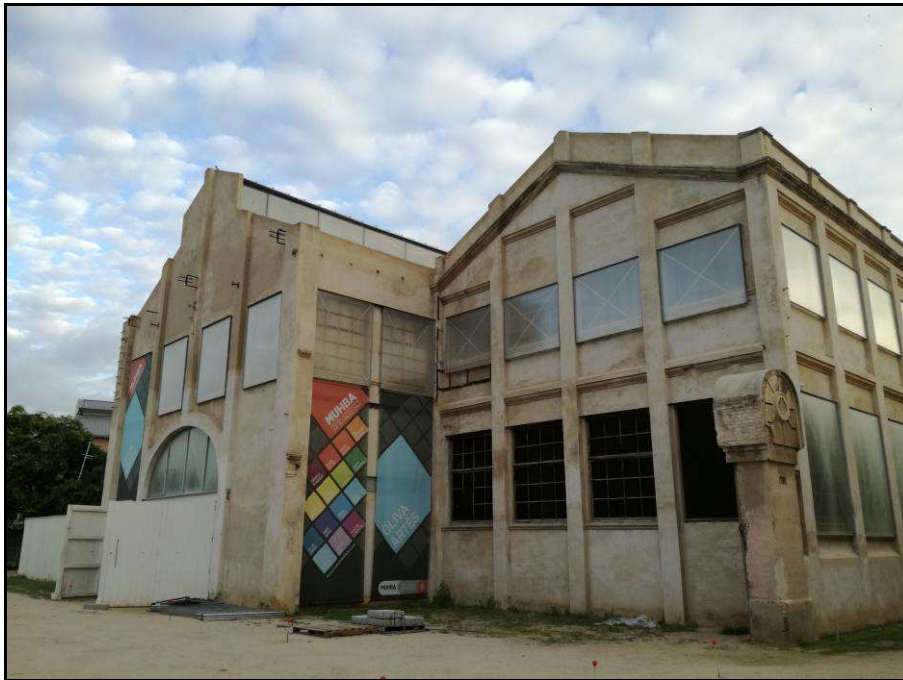
Fotografia núm. 1: exterior de la nau a l'inici de la intervenció
