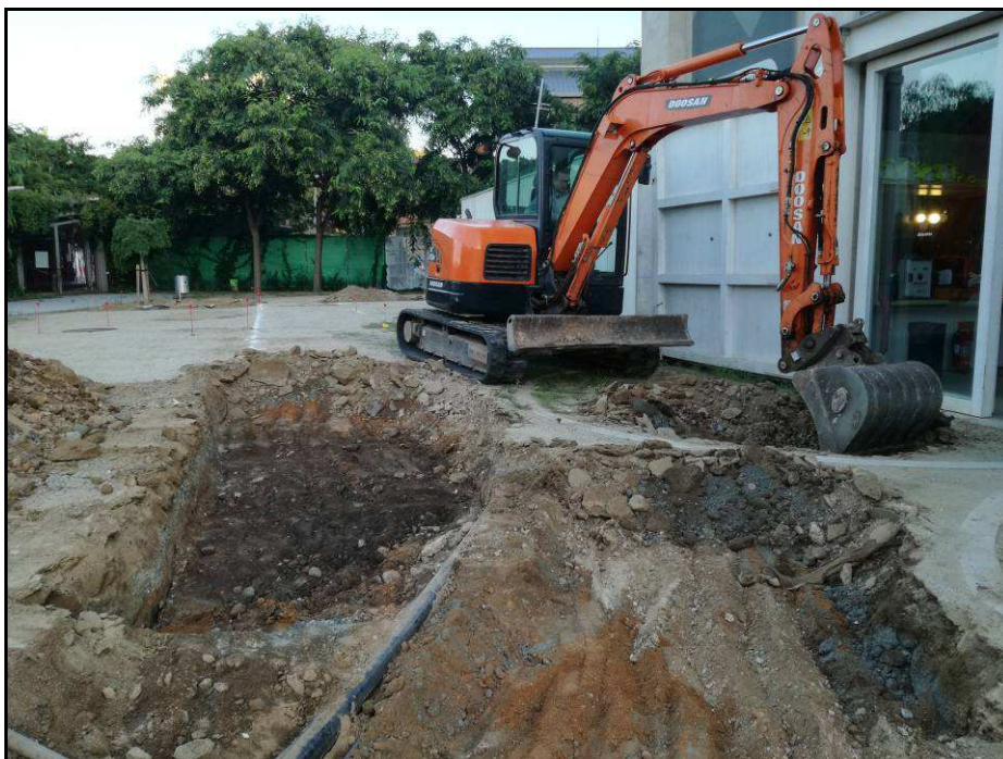
Fotografia núm. 10: execució del rebaix general sobre l'àrea del porxo
