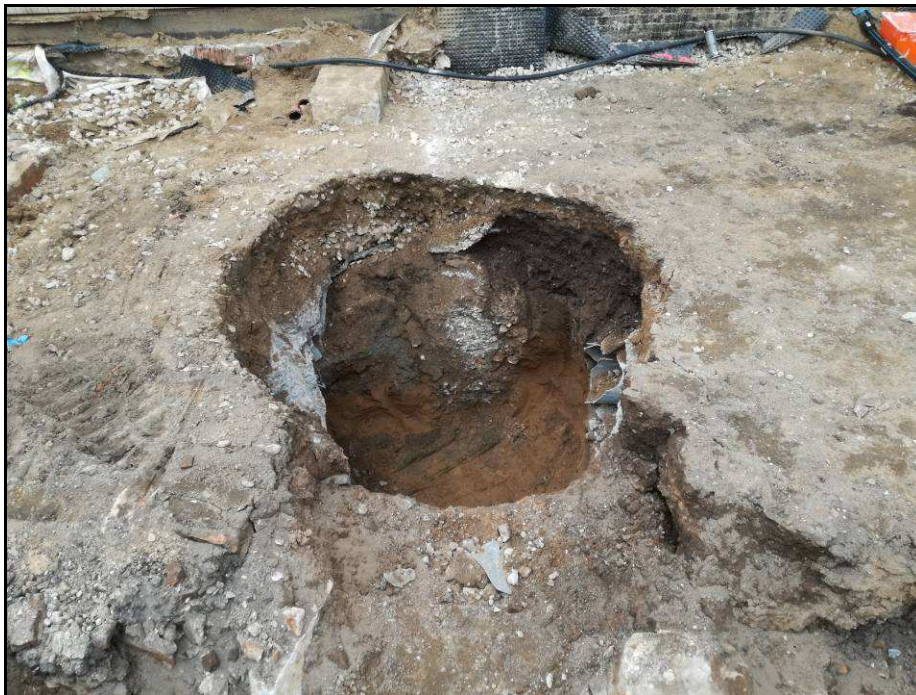
Fotografia núm. 73: restes del mur UE 1032
