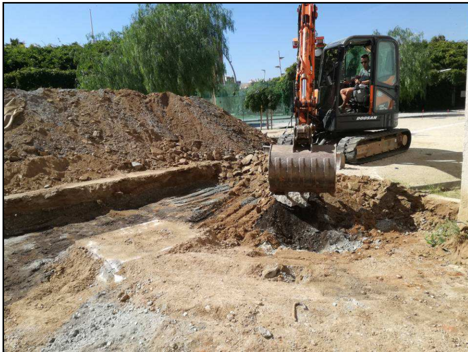
Fotografia núm. 9: execució del rebaix general sobre l'àrea del porxo
