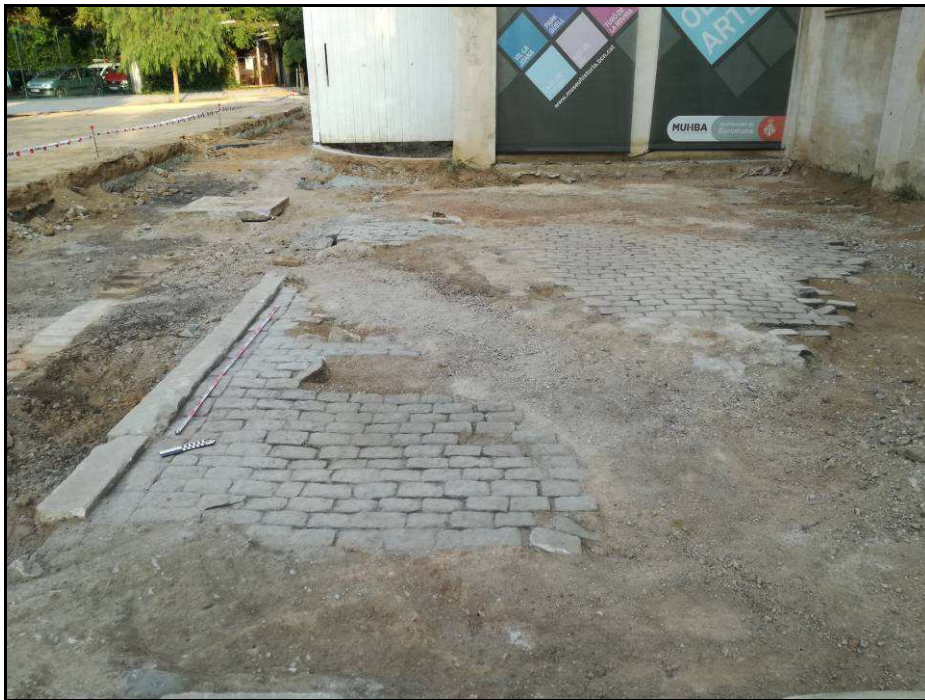
Fotografia núm. 23: paviment UE 1003, afectat per la rasa UE 1011
