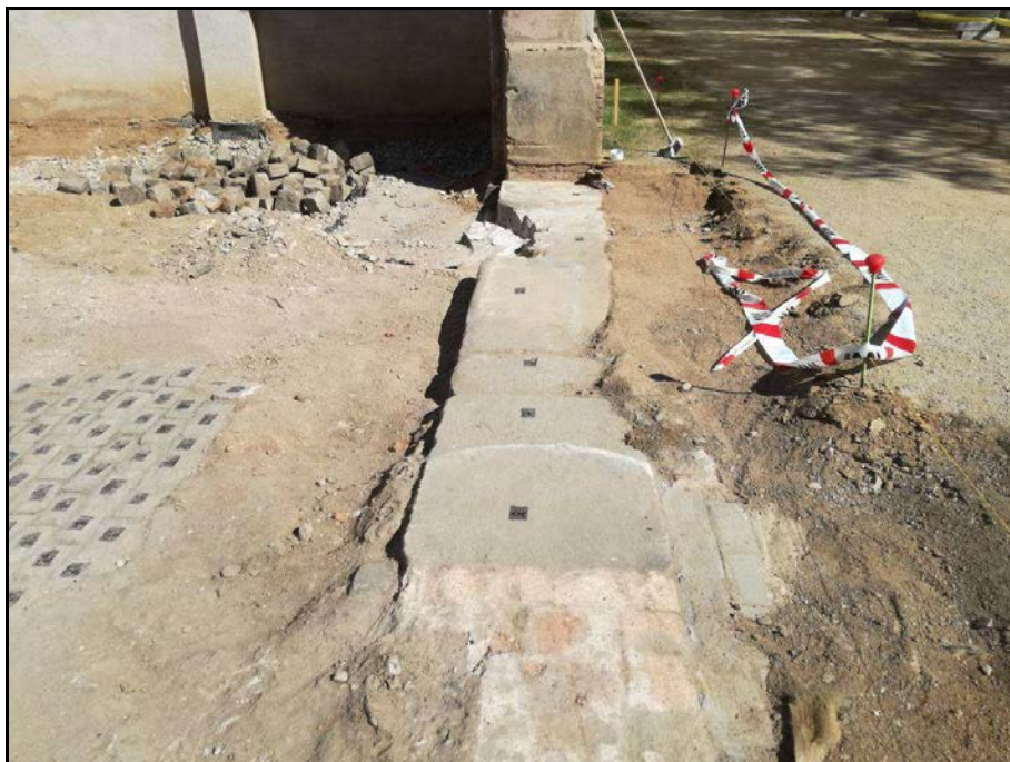
Fotografia núm. 36: numeració de les pedres de llinda del mur UE 1014
