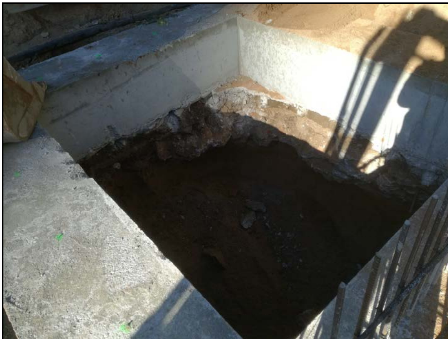
Fotografia núm. 88: Final de la primera fase del rebaix
