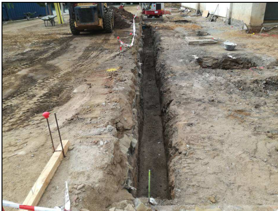
Fotografia núm. 49: obertura de rases per riostes i pous (rasa 1000)
