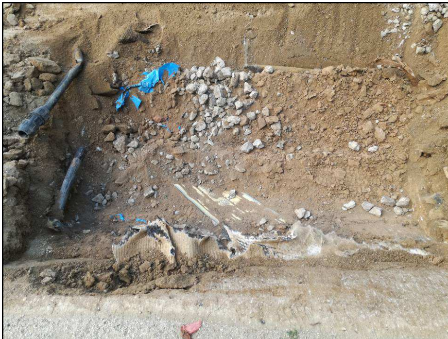
Fotografia núm. 17: serveis que afecten l'àrea del porxo
