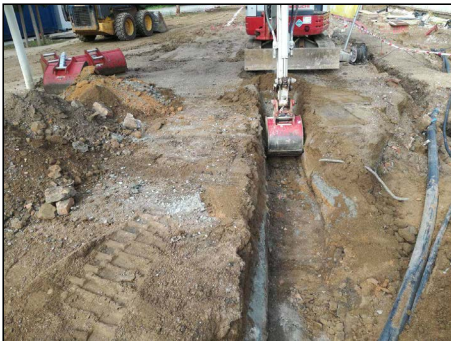
Fotografia núm. 42: obertura de la rasa 2000
