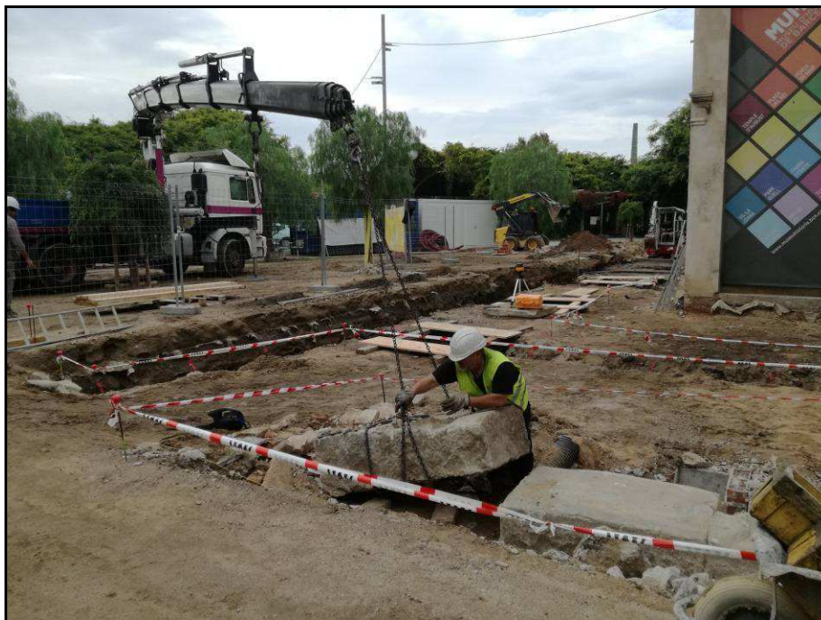
Fotografia núm. 39: desmuntatge de les pedres de llinda
