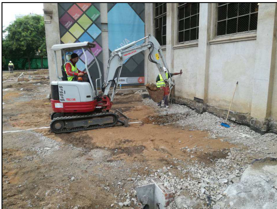
Fotografia núm. 50: obertura de rases per riostes i pous (rasa 1000)
