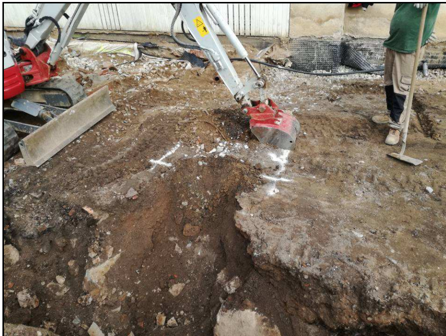
Fotografia núm. 52: obertura de rases per riostes i pous (rasa 1000)
