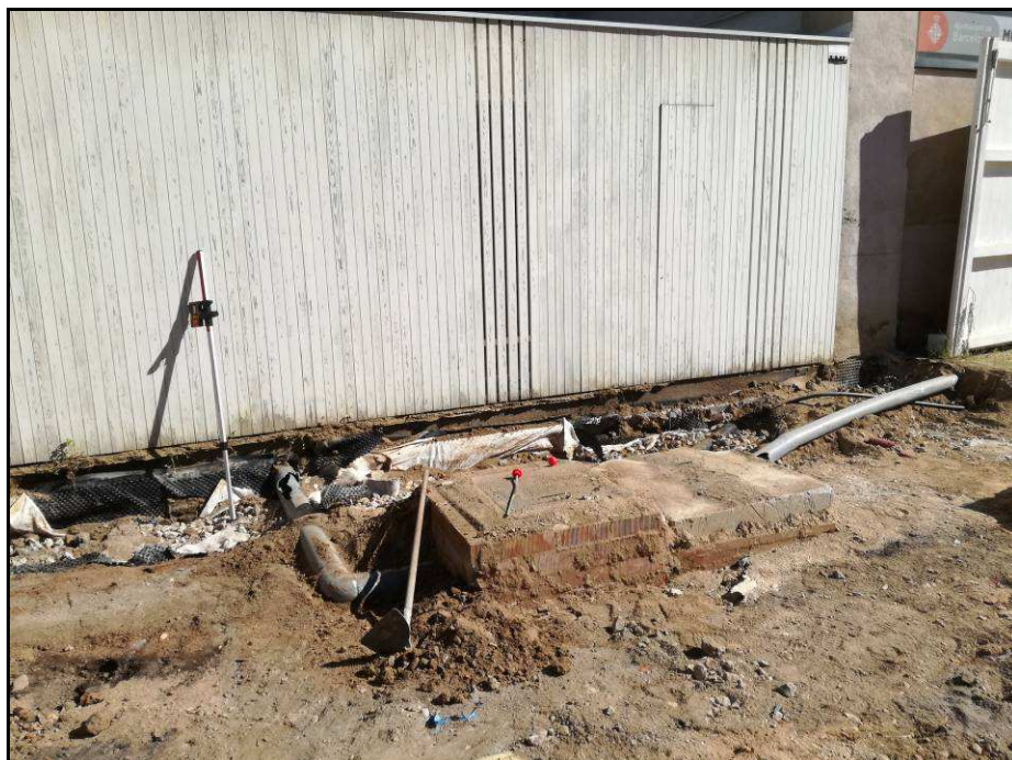
Fotografia núm. 18: serveis que afecten l'àrea del porxo
