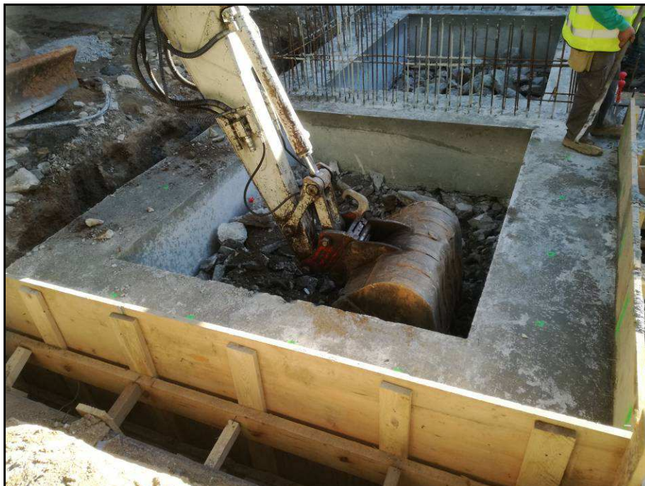
Fotografia núm. 84: Rebaix del fossat d'ascensor
