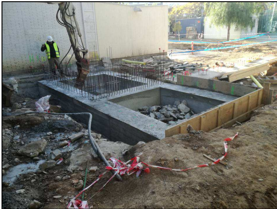
Fotografia núm. 83: Estructura del fossat d'ascensor abans d'iniciar el rebaix
