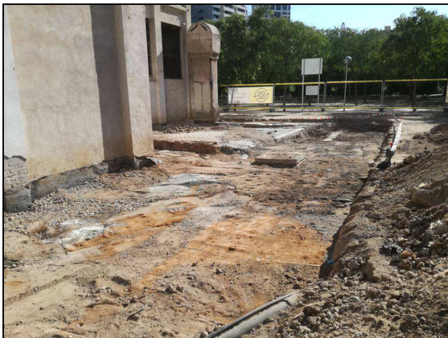
Fotografia núm. 14: rebaix general sobre l'àrea del porxo un cop finalitzat
