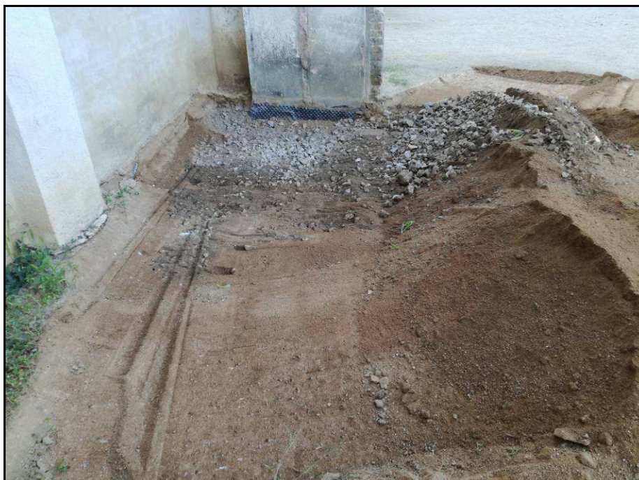
Fotografia núm. 22: farciment de graves de la rasa perimetral per al drenatge
