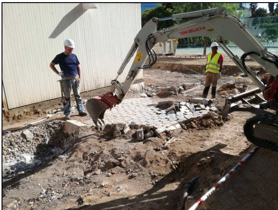
Fotografia núm. 38: desmuntatge del paviment UE 1003
