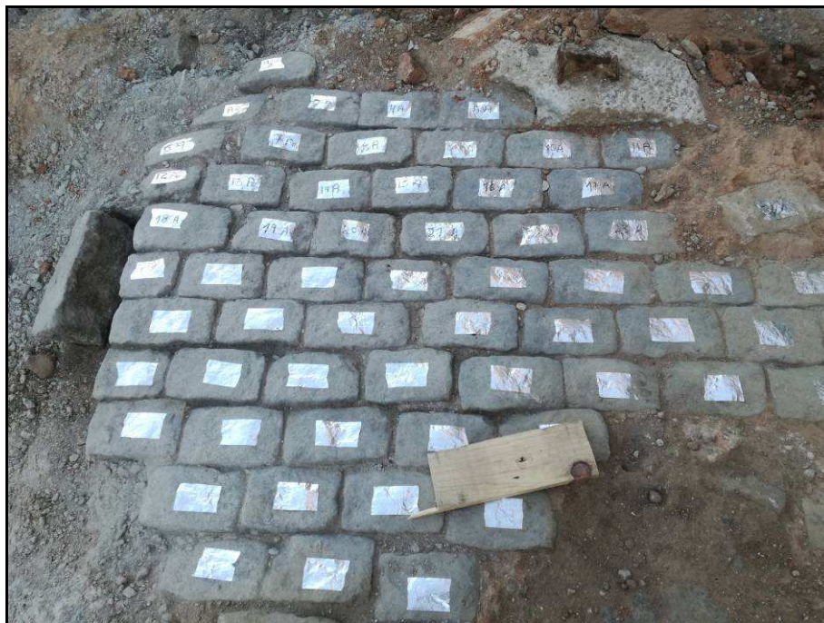
Fotografia núm. 35: numeració de les llambordes del paviment UE 1003
