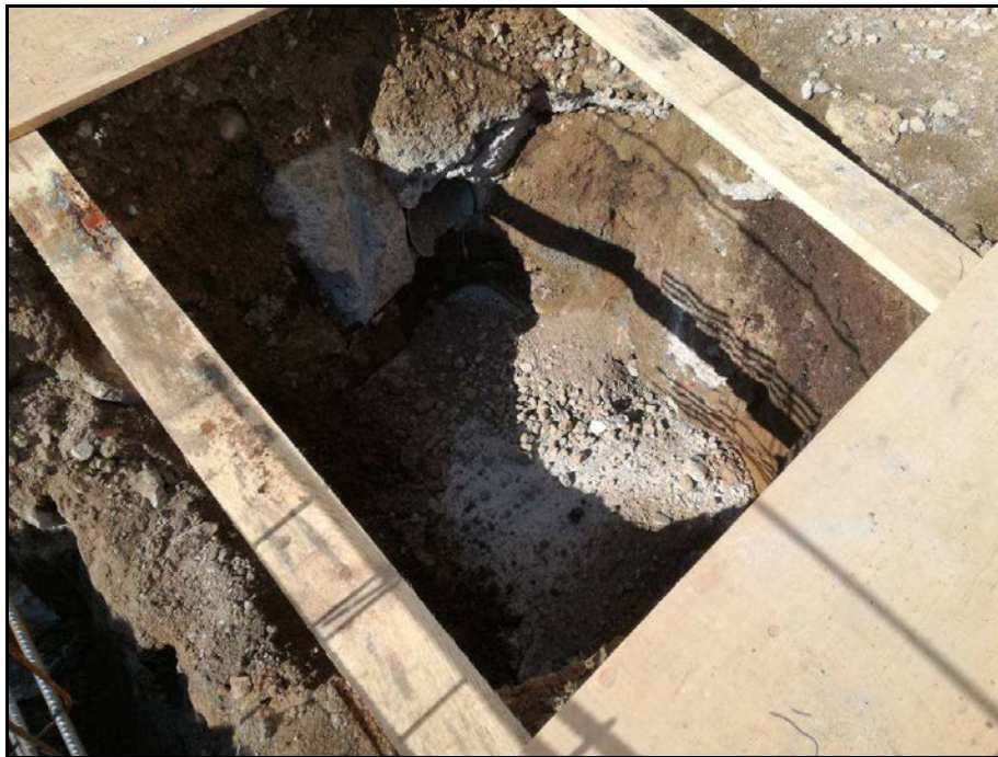
Fotografia núm. 61: pou 8, amb restes de la canalització d' aigües pluvials
