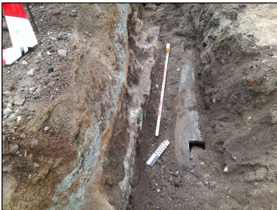
Fotografia núm. 69: mur UE 1017 i tub de formigó
