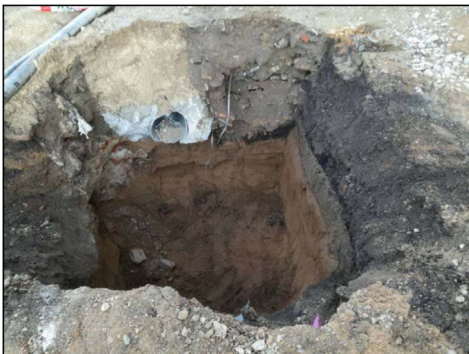
Fotografia núm. 64: pou 12, amb restes del mur UE 1009 i de la canalització d'aigües pluvials
