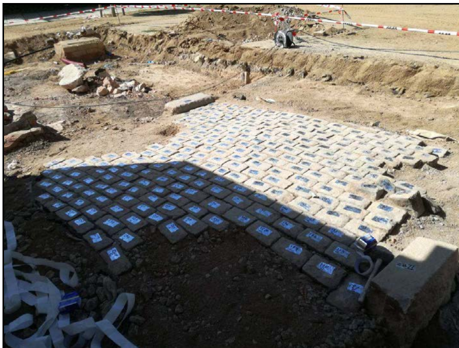
Fotografia núm. 37: numeració de les llambordes del paviment UE 1028
