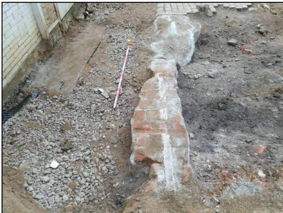
Fotografia núm. 33: mur UE 1029 i reparació UE 1031
