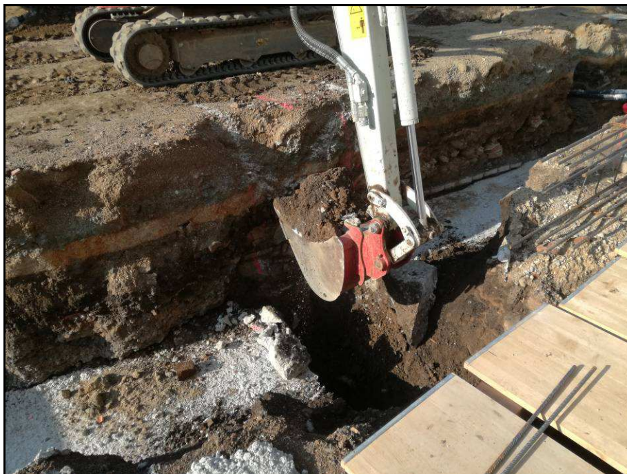
Fotografia núm. 53: obertura de rases per riostes i pous (rasa 1000)
